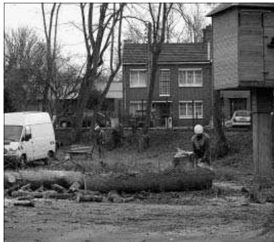
L'abattage des arbres malades, morts ou dangereux prépare le terrain pour des travaux qui commenceront ce lundi 14 janvier.
